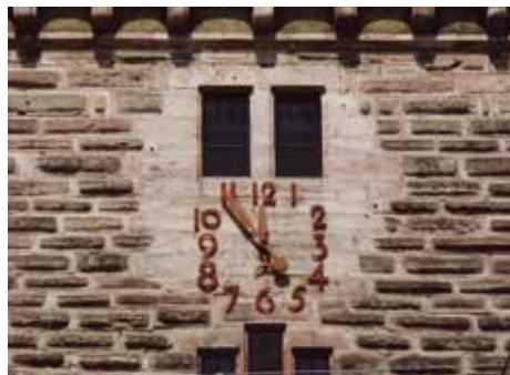
Die mit Stunden- und Minutenzeiger ausgestattete Turmuhr von 1932/33 mit arabischen Ziffern. Wieder sichtbar das früher durch das gotische Zifferblatt verdeckte Fensterpaar.
