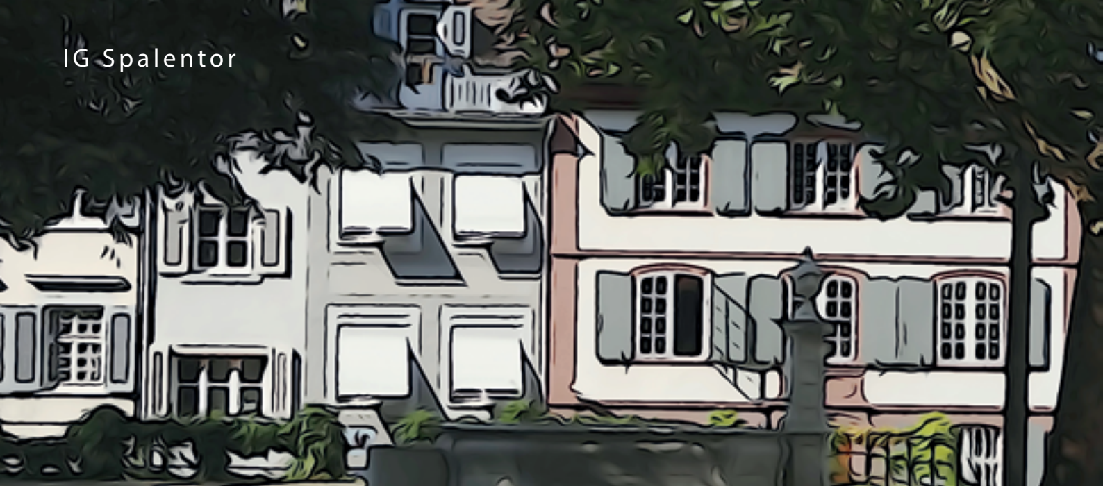
Fassaden der Häuser Petersplatz 16 bis 20. Vorne der Grabeneck-Brunnen (Foto:waf.)
