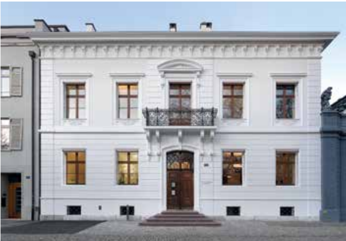
Die Fassade des 'Hauses der Krebsliga beider Basel' am Petersplatz 12, Foto: Serge Hasenböhler, Basel
